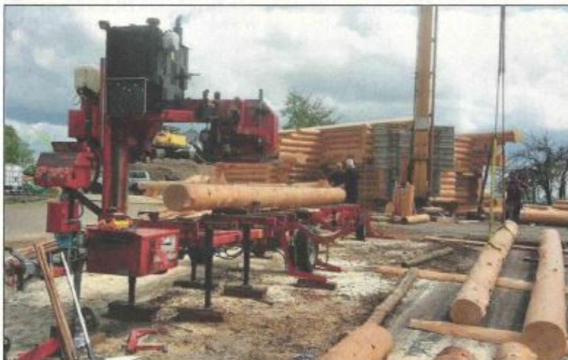
Stämme für den Blockhausbau werden direkt auf der Baustelle zurichtet.
